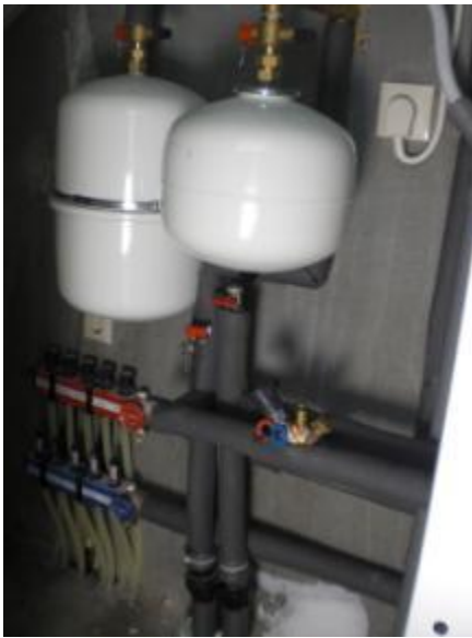
Voorbeeld opstelling WZS H/K onder trapkast
